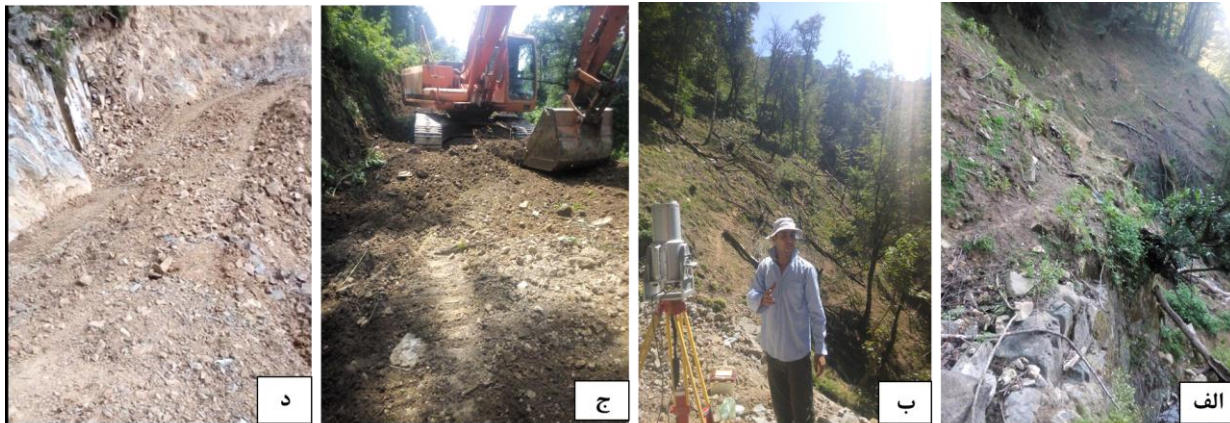
شکل ۲- تصاویری از مراحل اجرای پژوهش: الف) عرض پاک‌تراشی شده جاده؛ ب) برداشت مسیر جاده با ابزار لیزر اسکنر زمینی؛ ج) عملیات ساخت با دستگاه بیل مکانیکی؛ د) مقطع عرضی جاده بعد از اجرای عملیات خاکی.
